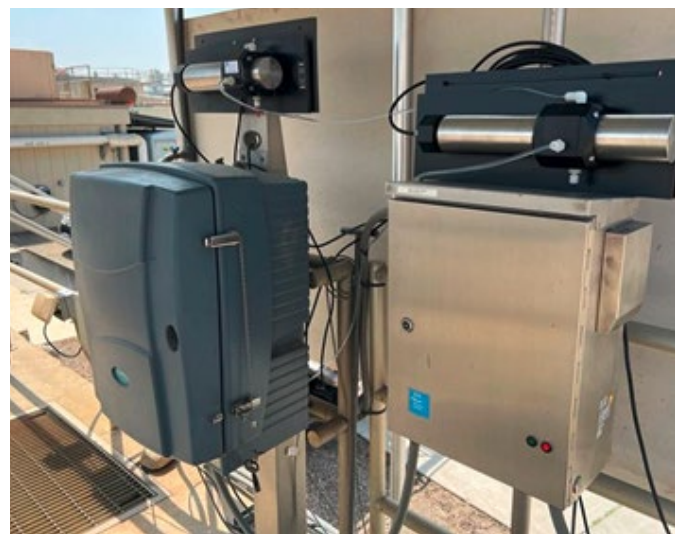
Imagen 2: Puntos de medición recomendados de nitrito y nitrato en una planta de tratamiento de aguas residuales
